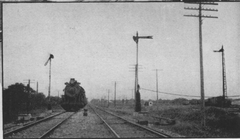
Type "F" Electric Interlocking—M. K. & T. and S. P. Rys.
