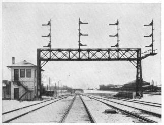
Fig. 2. Collinwood Interlocking Plant. L. S. & M. S. R'y
