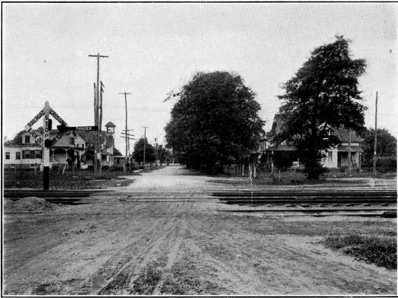
FIG. 19—Model 2-A Signal. 10 Volt Mechanism, Highway Crossing Signal, L. I. R. R. [ 18 ]
