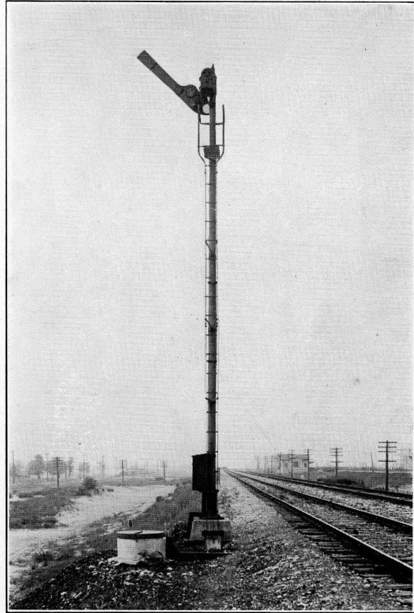
FIG. 13—Model 2-A Signal. 10 Volt Mechanism Automatic Block System, B. & O. R. R.
