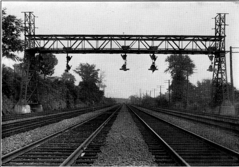
FIG. 17—Model 2-A. A. C. Suspended Signals, N. Y., N. H. & H. R. R., Woodside, N. Y.
