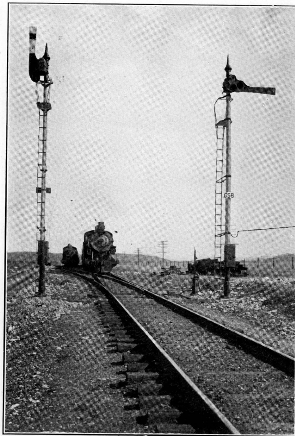
FIG. 15—Model 2-A Signal. 10 Volt Mechanism, Automatic Block System, N. P. R. R.
