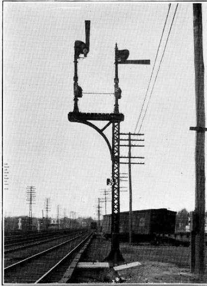
FIG. 16—Model 2-A Signal. A. C. Mechanism, Automatic Block System, L. I. R. R.
